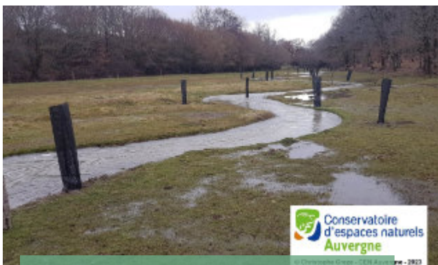
Travaux de reméandrage du ruisseau d'Auze par le CEN, mise en défends (pose de clôture) du ruisseau et restauration de la zone humide associée.
