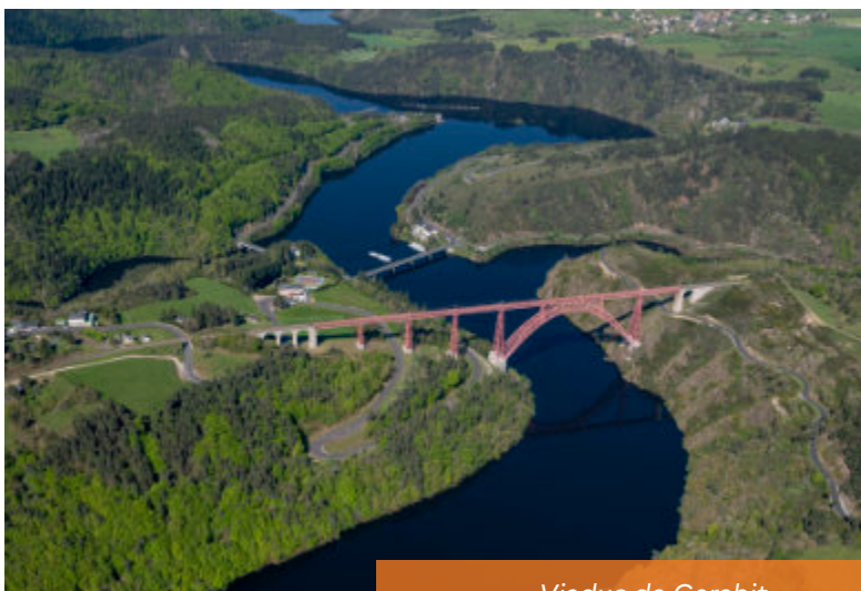
Viaduc de Garabit
